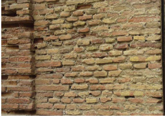
صورة ٠٤ . تقنية الصفوف من الأجر (عن الباحثين) (Opus testacium)
